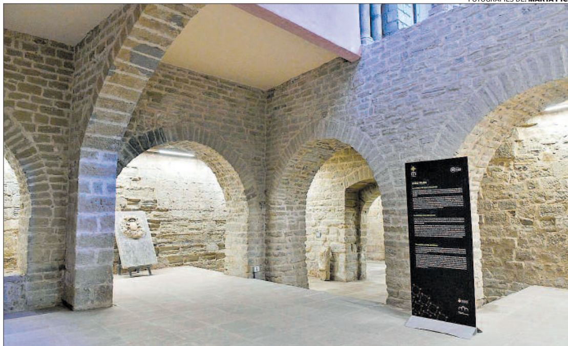
Fent angle, les dues arcades que es conserven del segle XI que va fer possible la redotació de la Seu
