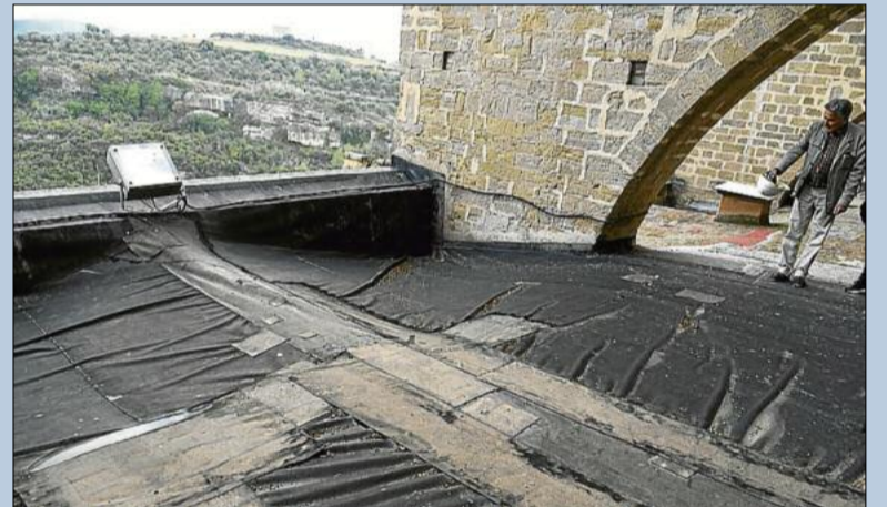
Al terrat trauran el que hi ha ara i hi posaran una tela asfàltica i rajoles
