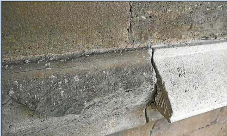
Una cornisa amb la pedra tal com estava i la part refeta, a la dreta
