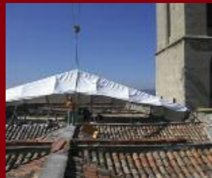
2003-2004. Consolidació estructural i coberta
